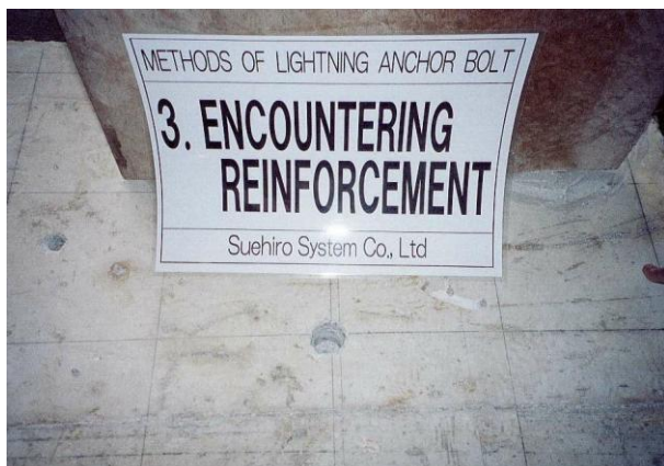
<穿孔位置に鉄筋干渉>
