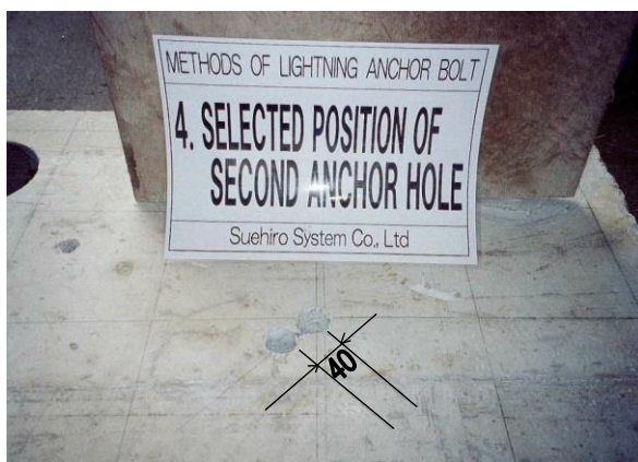
<第 2 アンカーボルト孔の穿孔>
