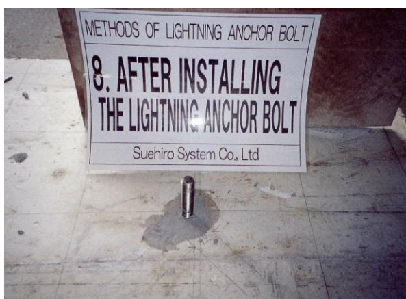
<イナズマアンカーボルト取付完了>
