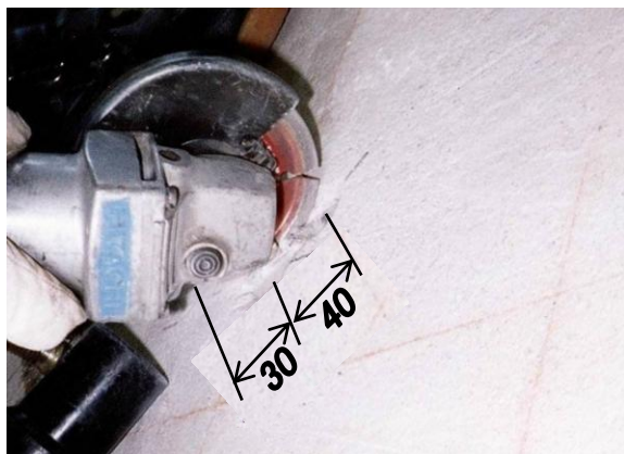
＜コンクリート表面をカッター切り＞
