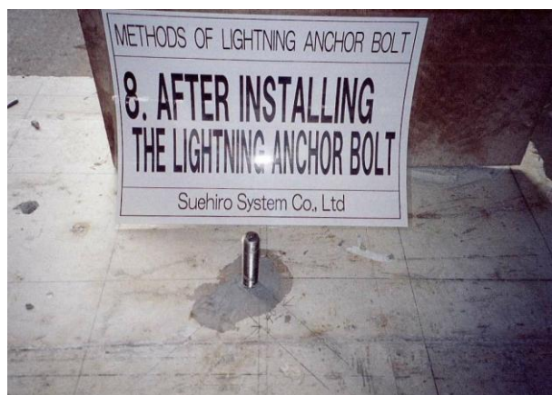
<イナズマアンカーボルト取付完了>
