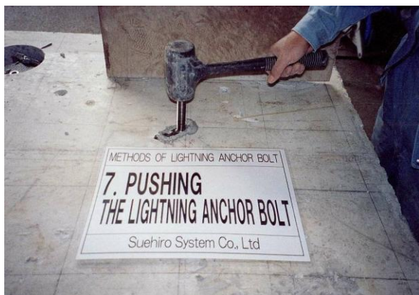
<イナズマアンカーボルト取付>
