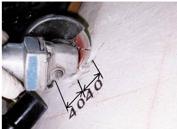
＜コンクリート表面をカッター切り＞
