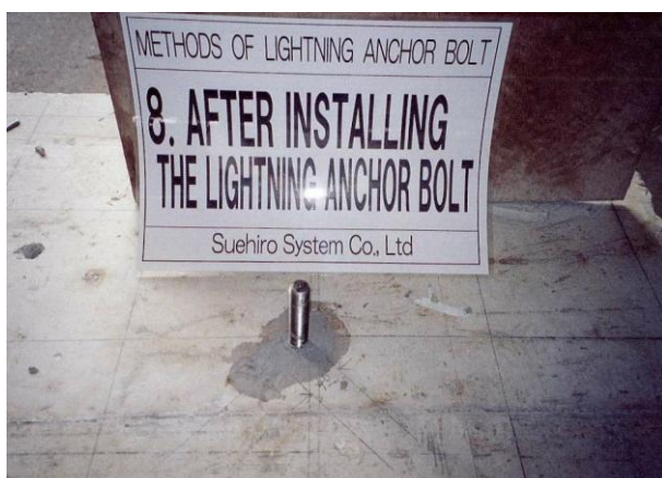
<イナズマアンカーボルト取付完了>
