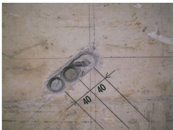
＜アンカーボルト孔連結＞
