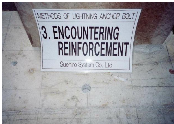
＜穿孔位置に鉄筋干渉＞
