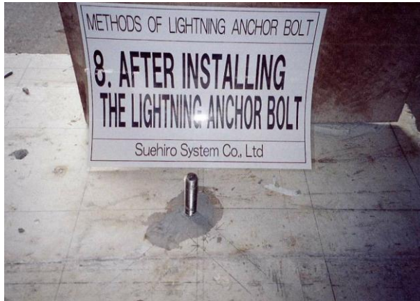
<イナズマアンカーボルト取付完了>
