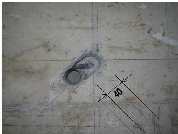
＜アンカーボルト孔連結＞
