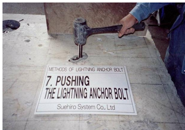
＜イナズマアンカーボルト取付＞
