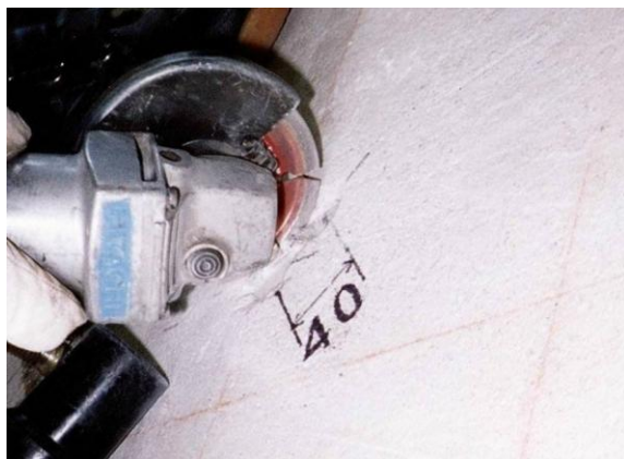
＜コンクリート表面をカッター切り＞
