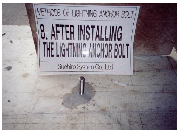
<イナズマアンカーボルト取付完了>
