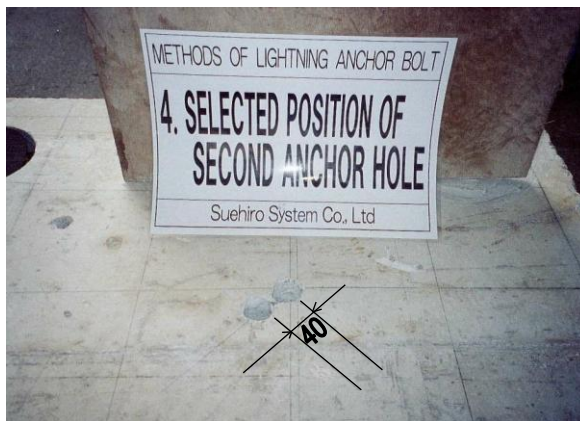
＜第 2 アンカーボルト孔の穿孔＞
