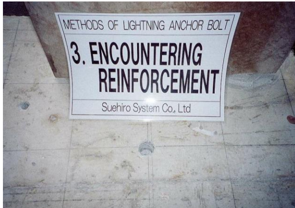
＜穿孔位置に鉄筋干渉＞
