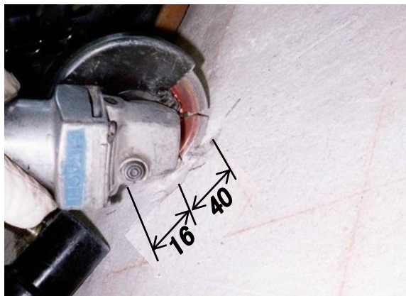
＜コンクリート表面をカッター切り＞
