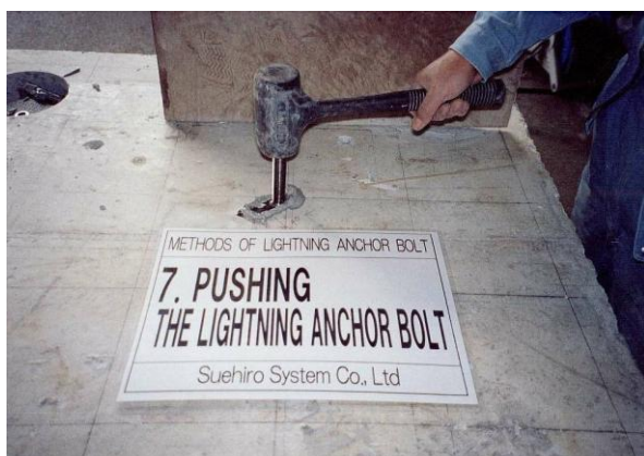
<イナズマアンカーボルト取付>
