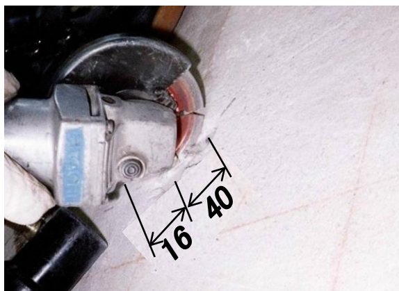
＜コンクリート表面をカッター切り＞
