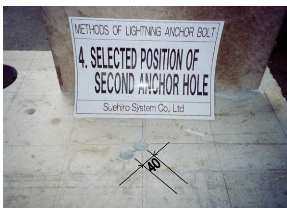
＜第 2 アンカーボルト孔の穿孔＞
