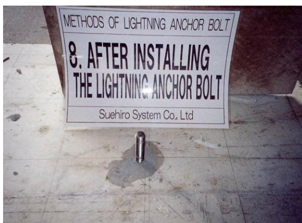
<イナズマアンカーボルト取付完了>
