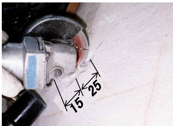
＜コンクリート表面をカッター切り＞
