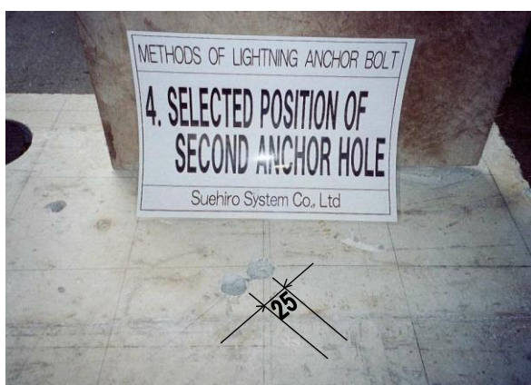
＜第 2 アンカーボルト孔の穿孔＞
