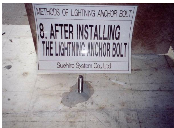
<イナズマアンカーボルト取付完了>
