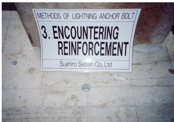
＜穿孔位置に鉄筋干渉＞
