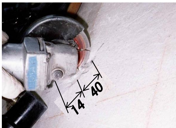
＜コンクリート表面をカッター切り＞
