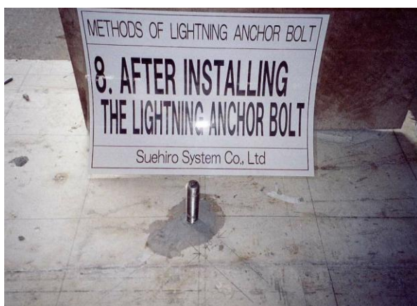
<イナズマアンカーボルト取付完了>
