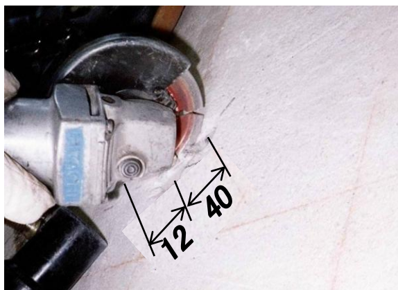
＜コンクリート表面をカッター切り＞
