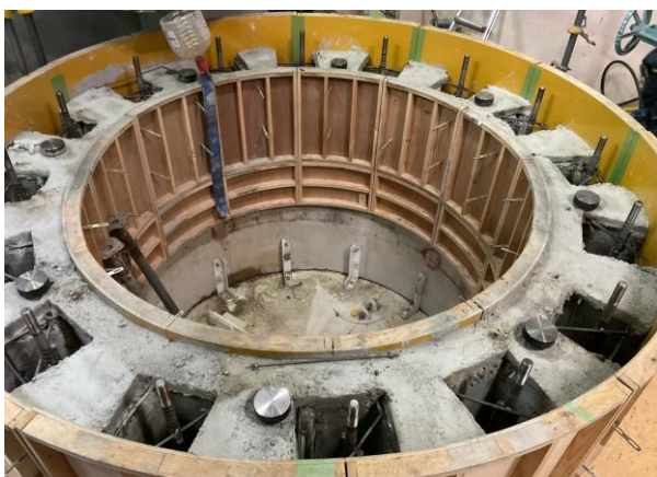
アンカー体型ライナーを仮ライナーとして使用
