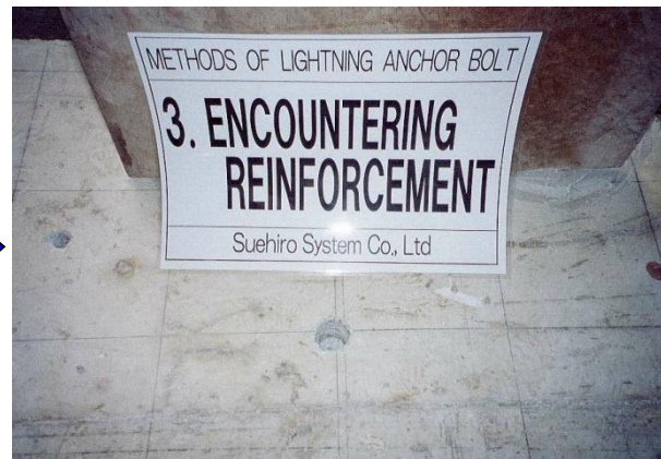
<穿孔位置に鉄筋干渉>
