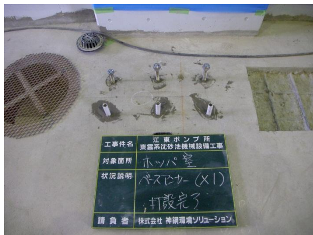
＜アンカー打設＞
