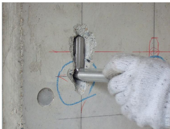
<M16 新型イナズマアンカー仮挿入>
