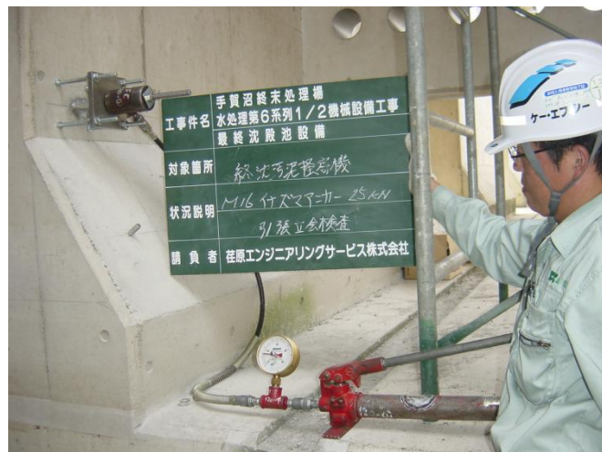
<引抜荷重 25KN 異常なし>
