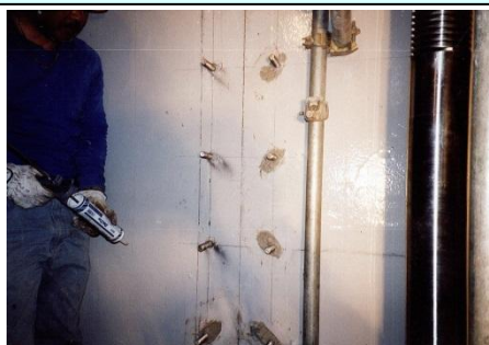
<アンカー打設>
