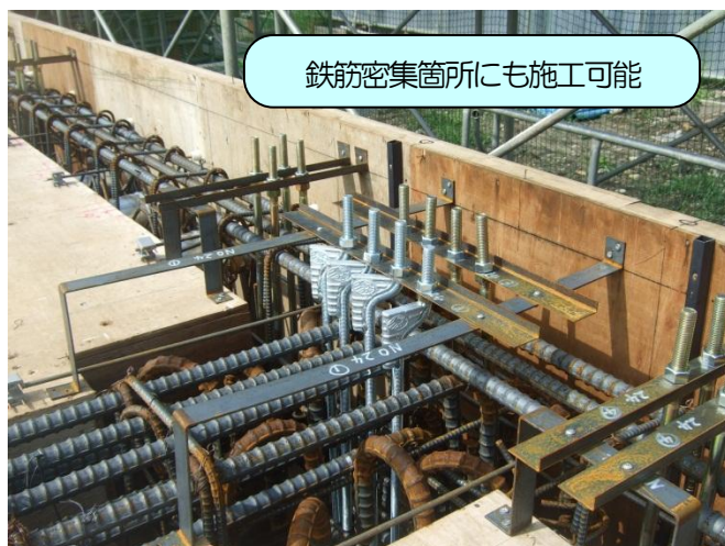
＜梁中にアンカーボルト取付 側面図＞
