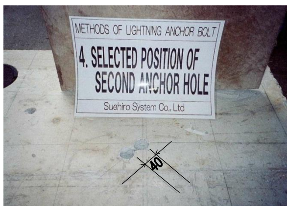
<第2アンカーボルト孔の穿孔>
