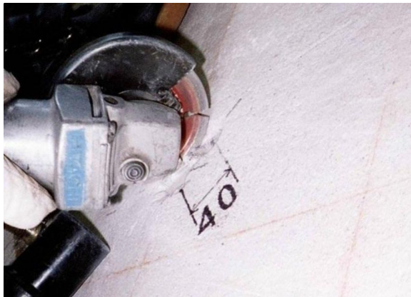
＜コンクリート表面をカッター切り＞
