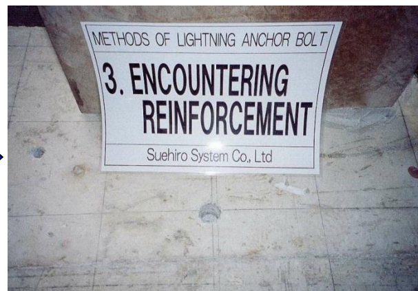
<穿孔位置に鉄筋干渉>
