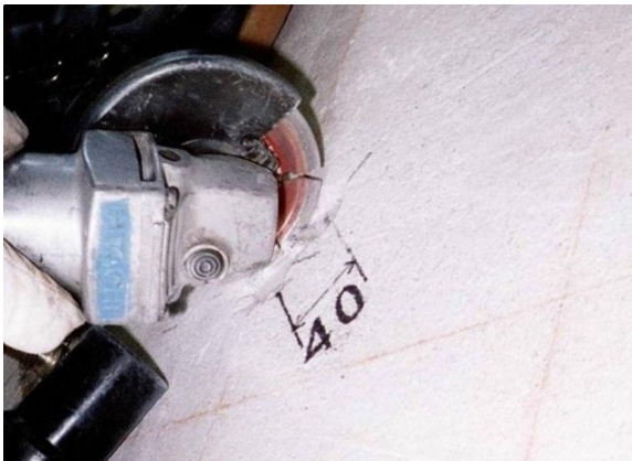
＜コンクリート表面をカッター切り＞
