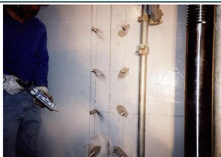
<アンカー打設>
