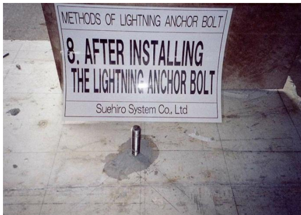
<イナズマアンカーボルト取付完了>
