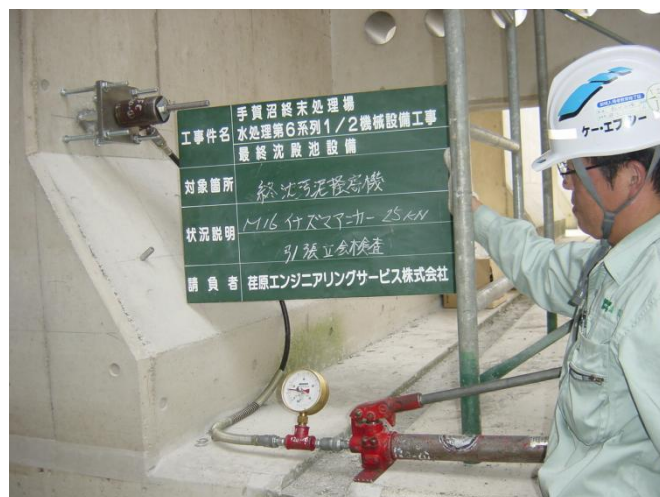
<引抜荷重 25KN 異常なし>
