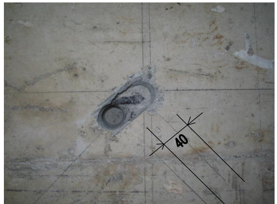
＜アンカーボルト孔連結＞
