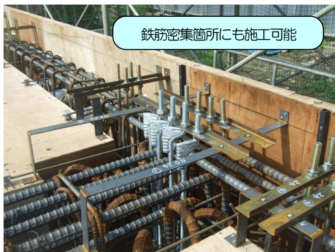
＜梁中にアンカーボルト取付 側面図＞
