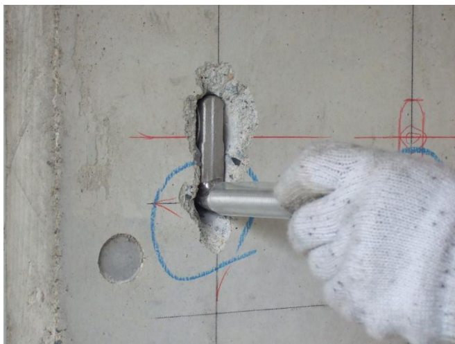
<M16 新型イナズマアンカー仮挿入>
