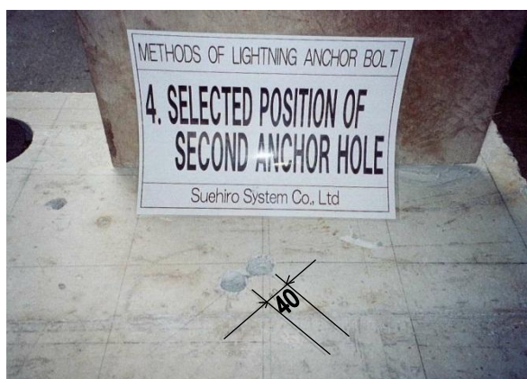
<第2アンカーボルト孔の穿孔>
