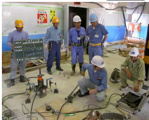
＜アンカー引抜試験＞
