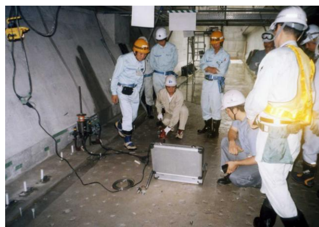
＜アンカー引抜試験＞
