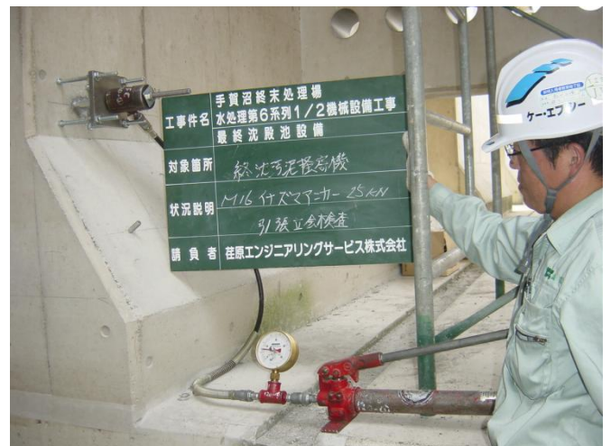
<引抜荷重 25KN 異常なし>
