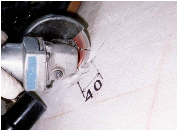
＜コンクリート表面をカッター切り＞
