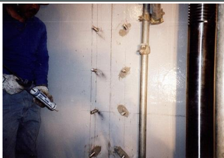
<アンカー打設>
