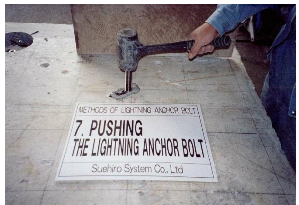
＜イナズマアンカーボルト取付＞
