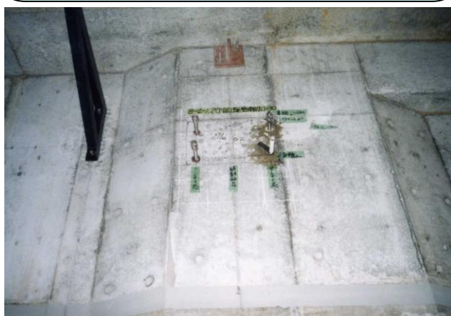
＜アンカー打設＞
