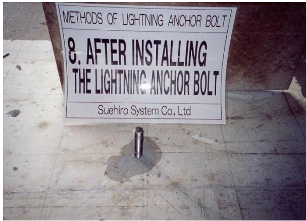
＜イナズマアンカーボルト取付完了＞
