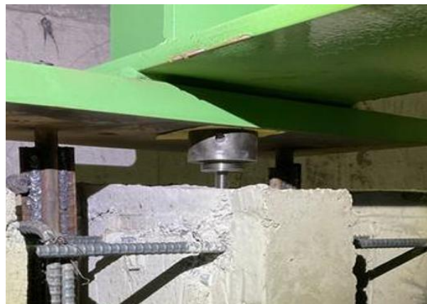
アンカー体型ライナーで芯だし所要時間を50%低減
