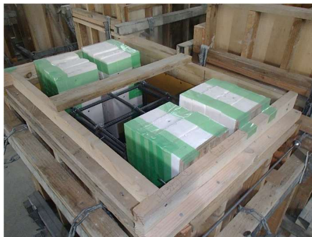
機械基礎 [箱抜き穴 型枠]
