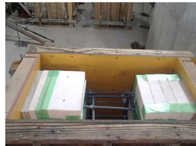
機械基礎 [箱抜き穴 型枠]
