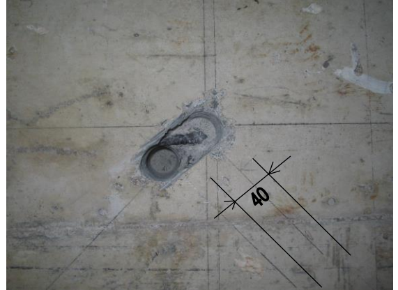
<连接地脚螺栓孔>
