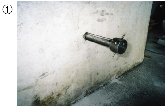
将锚固部分打入侧壁。
