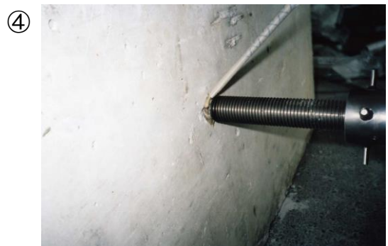
在与混凝土的缝隙充填树脂。
