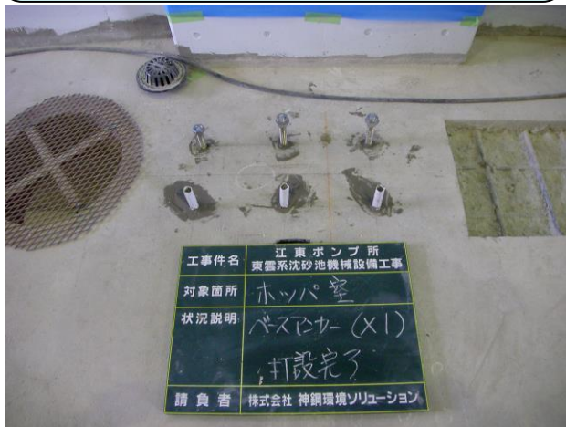
< 打入地脚螺栓 >
