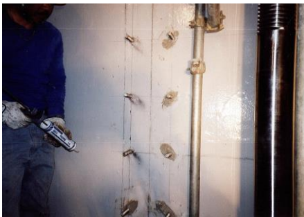
<打入地脚螺栓>
