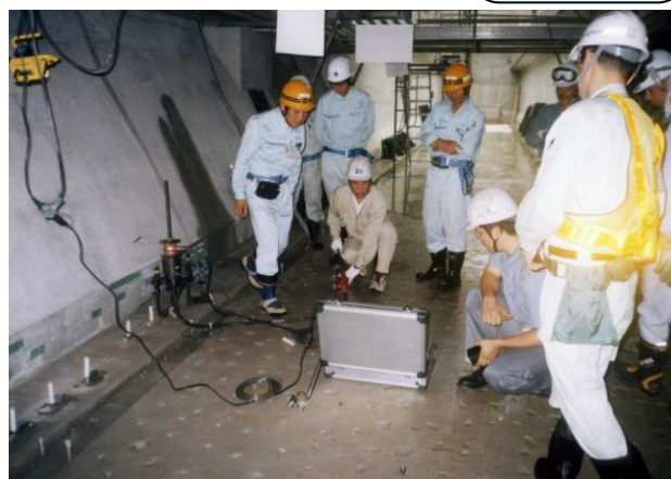
< 地脚螺栓拔出试验 >
