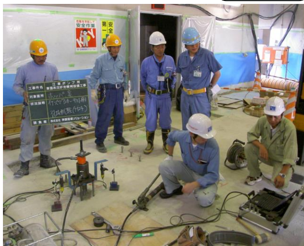
< 地脚螺栓拔出试验 >
