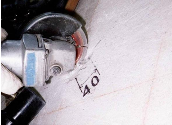
<切割混凝土表面>
