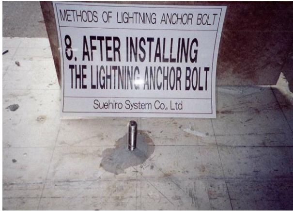
<偏心地脚螺栓安装完毕>
