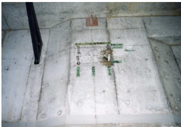
< 打入地脚螺栓 >
