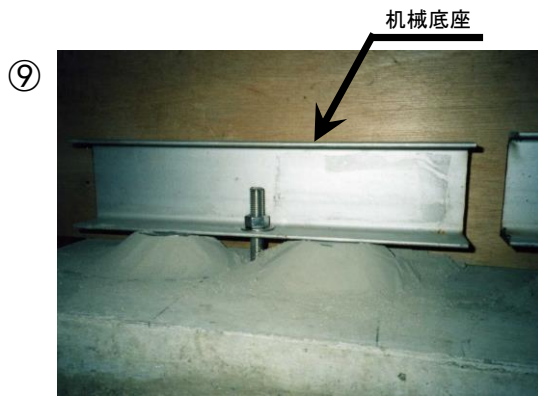
调整完毕后，用膨胀混凝土固定周围。
