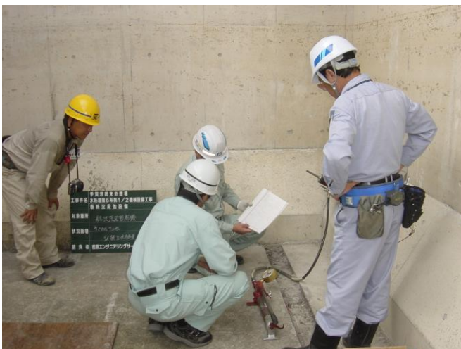
<政府机关到场对 M16 新型偏心地脚螺栓的试验>
