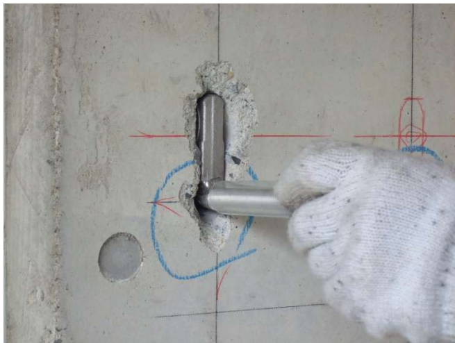
＜M16 新型イナズマアンカー仮挿入＞
