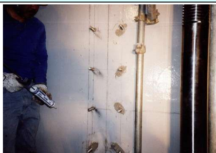
＜アンカー打設＞
