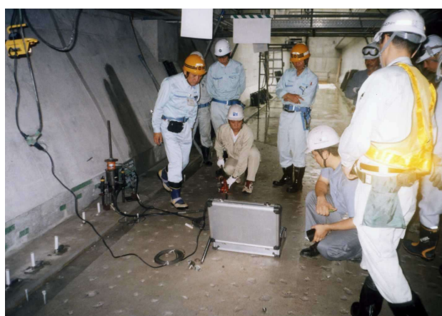
<アンカー引抜試験>
