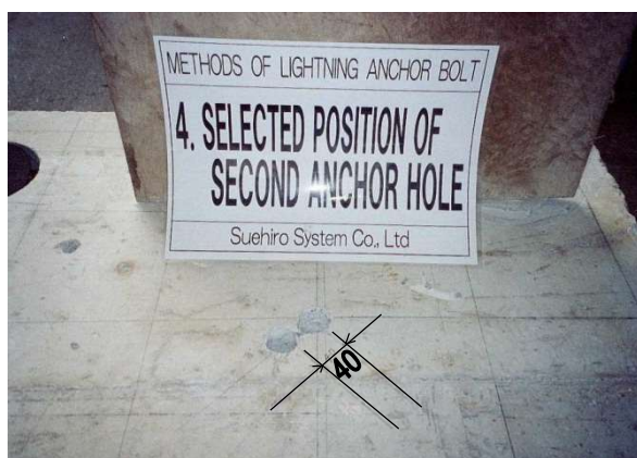
<第2 アンカーボルト孔の穿孔>
