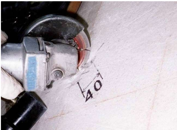
＜コンクリート表面をカッター切り＞
