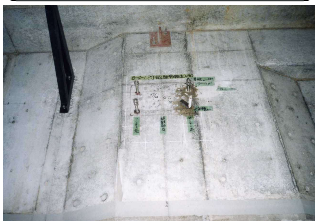
<アンカー打設>
