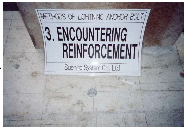
<穿孔位置に鉄筋干渉>
