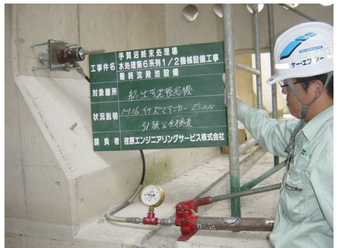
＜引抜荷重 25kN 異常なし＞
