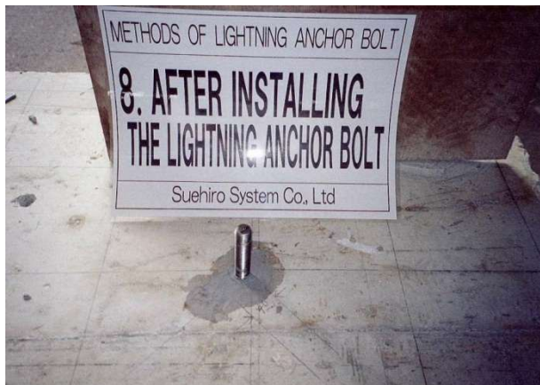
<イナズマアンカーボルト取付完了>
