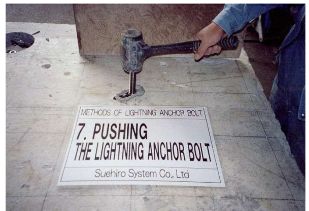
＜イナズマアンカーボルト取付＞
