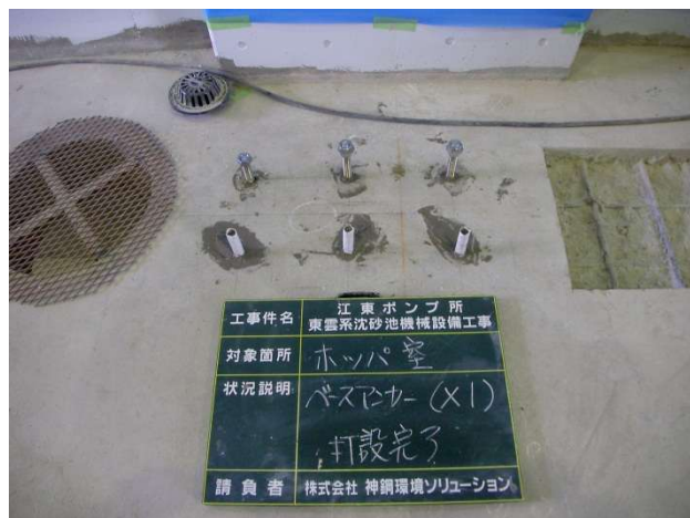
<アンカー打設>
