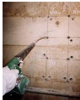
＜8ヶ所の内、7箇所イナズマアンカーボルト使用＞
