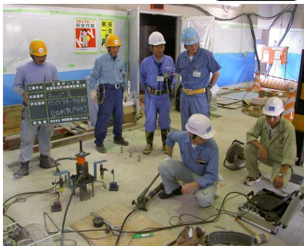
<アンカー引抜試験>
