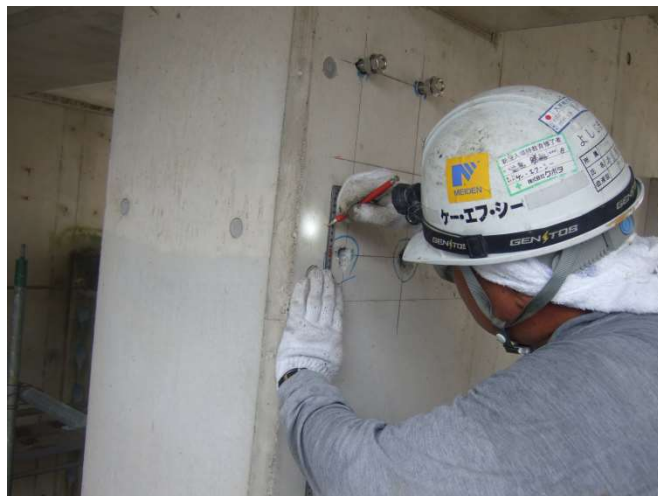
上段：ケミカルアンカー-M16 下段：鉄筋干渉イナズマアンカー墨出し
