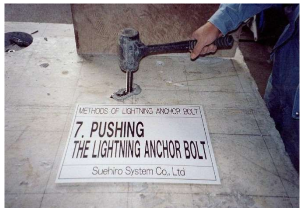
<イナズマアンカーボルト取付>
