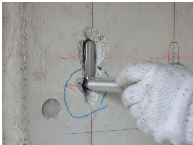
<M16 新型イナズマアンカー仮挿入>
