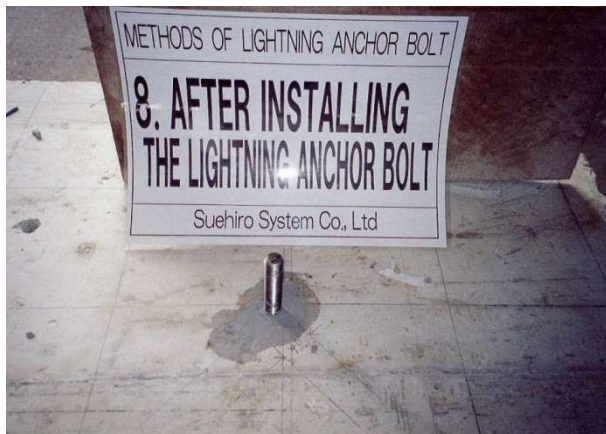
<イナズマアンカーボルト取付完了>
