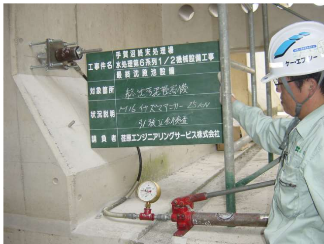
<引抜荷重 25kN 異常なし>
