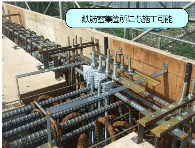
<梁中にアンカーボルト取付 側面図>
