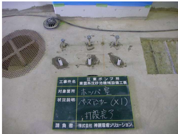
<アンカー打設>
