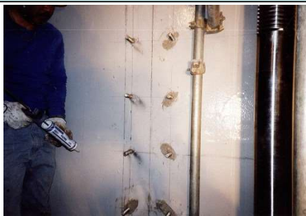
<アンカー打設>
