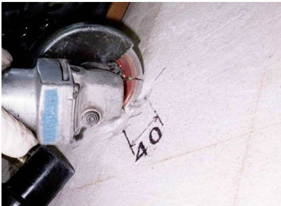
<コンクリート表面をカッター切り>
