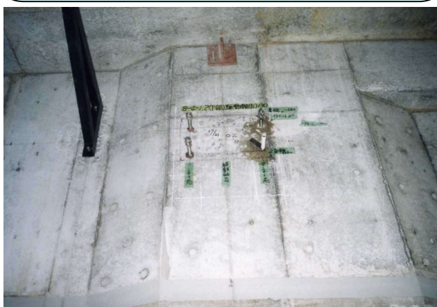
<アンカー打設>
