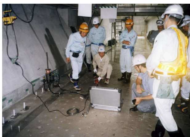
<アンカー引抜試験>
