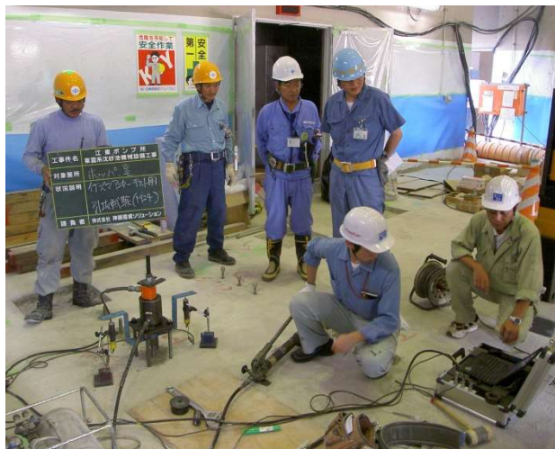
<アンカー引抜試験>
