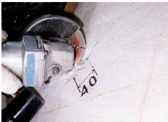
＜コンクリート表面をカッター切り＞
