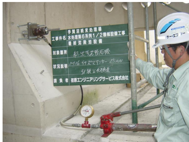
<引抜荷重 25KN 異常なし>
