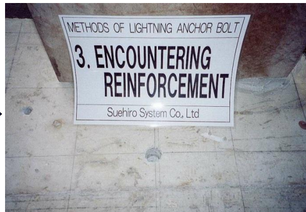
<穿孔位置に鉄筋干渉>
