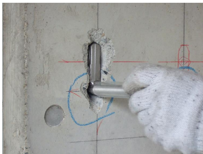
<M16 新型イナズマアンカー仮挿入>
