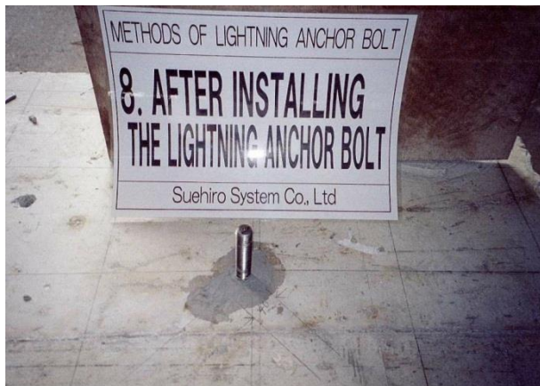
<イナズマアンカーボルト取付完了>
