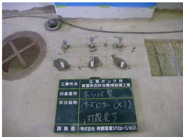
＜アンカー打設＞
