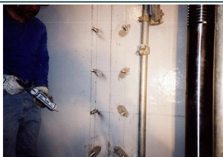
＜アンカー打設＞
