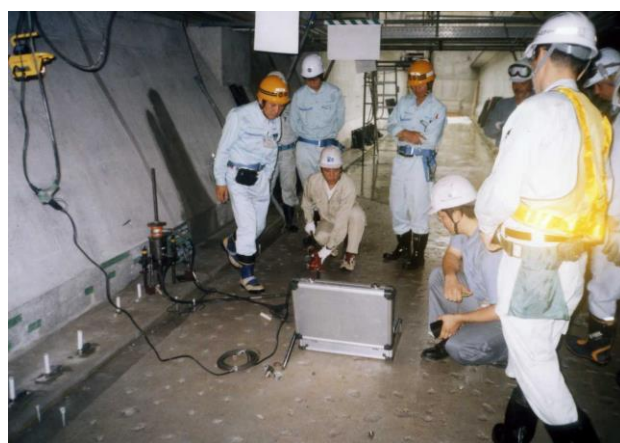
＜アンカー引抜試験＞
