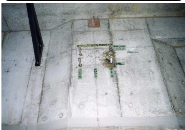
＜アンカー打設＞
