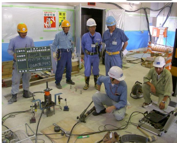
＜アンカー引抜試験＞
