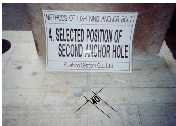
<第2アンカーボルト孔の穿孔>
