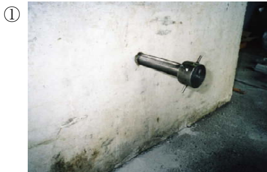
横壁にアンカ部を打ち込む。
