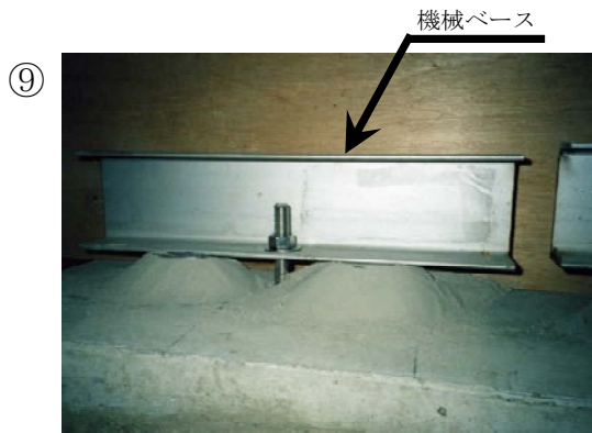
調整終了後、無収縮コンクリートで回りを固める。
