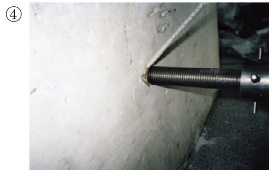
コンクリートとのスキマに樹脂を充填する。
