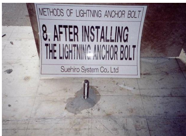
<イナズマアンカーボルト取付>
