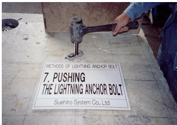
<イナズマアンカーボルト取付完了>
