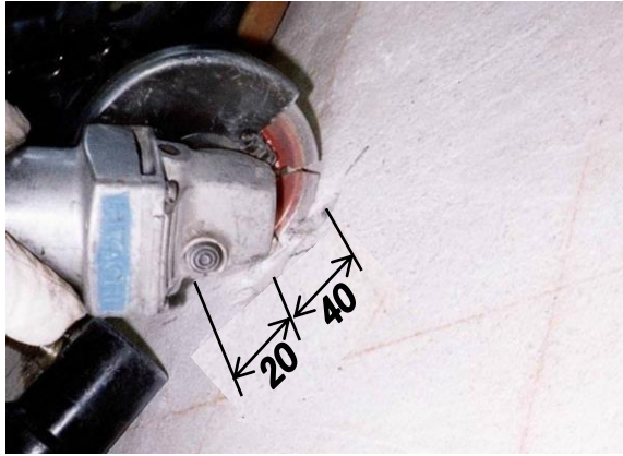
<コンクリート表面をカッター切り>
