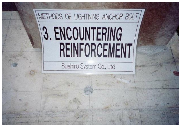
<穿孔位置に鉄筋干渉>
