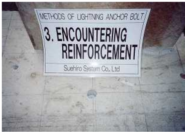
< 穿孔位置に鉄筋干渉 >
