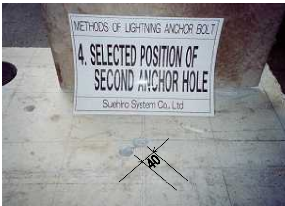
< 第 2 アンカーボルト孔の穿孔 >
