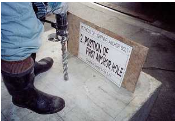
<マーキング及びアンカーボルト孔穿孔>
