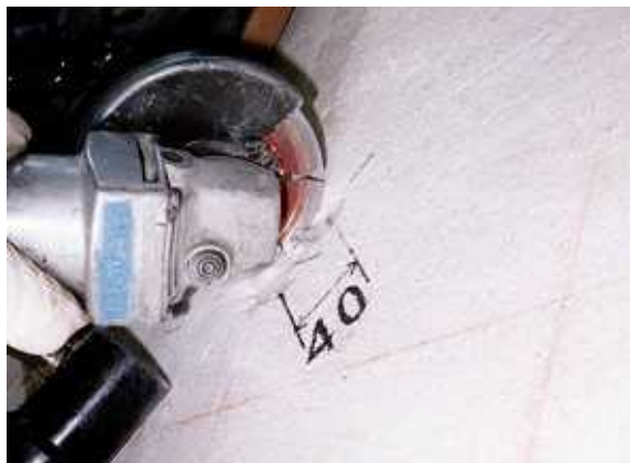
< コンクリート表面をカッター切り >
